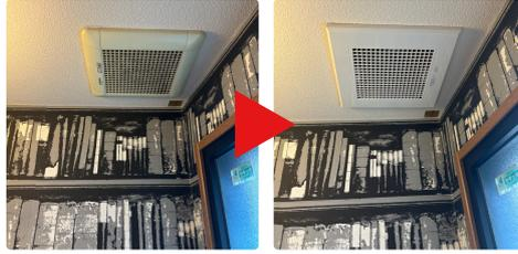
既存の換気扇から異音が発生し、吸い込み力が低下していたため、三菱電機の換気扇に交換いたしました。モーターや配線のチェックを行い、スムーズな動作を確認しております。
