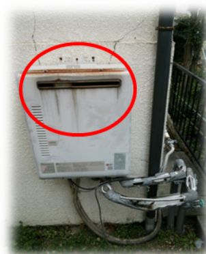
ガス給湯器の 不完全燃焼で 異音がする。
