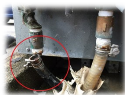
ガス給湯器の接続部 水道管の劣化での 水漏れ。
