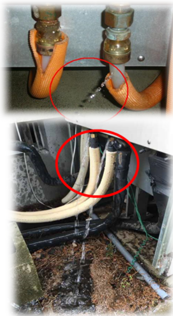
エコキュートの接続部 水道管の劣化での 水漏れ。
